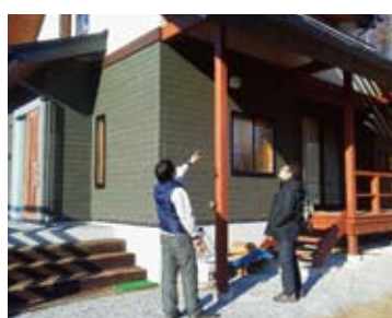
建物：宮坂建設施工
